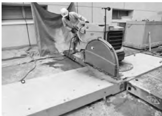
写真4 床版切断状況 (1m/分程度)
