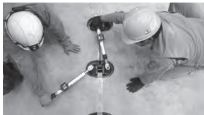
写真-2 コッター床版の施工方法
