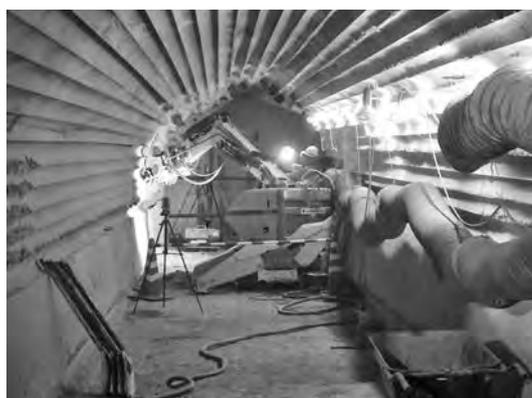
写真一 13 側壁切削状況
