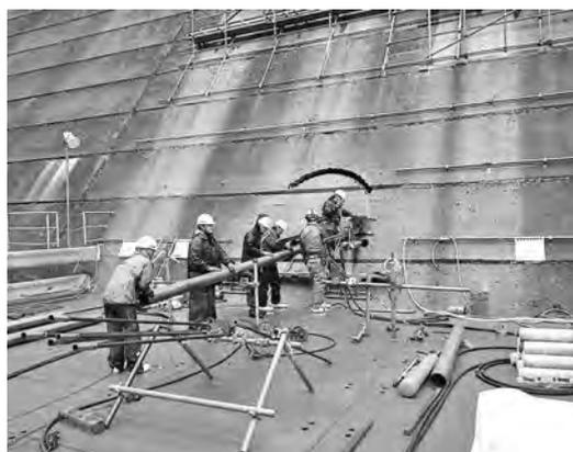
写真一 コアボーリング施工状況
