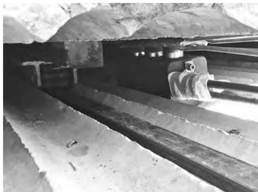
写真二 割裂状況 (バスター工法)
