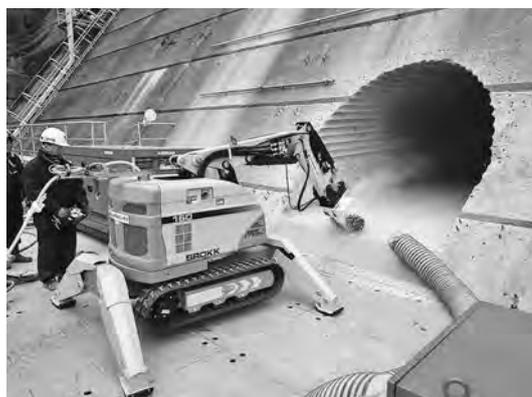
写真一 11 底盤切削状況
