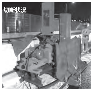
写真—8 施工状況
