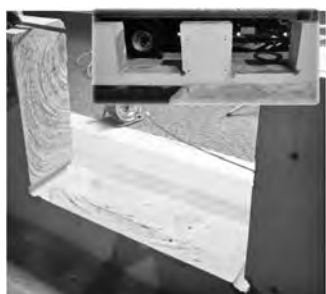
写真—9 切断撤去後の切断面
