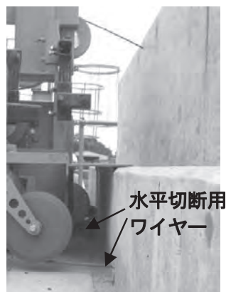
写真一六 水平面の切断状況
