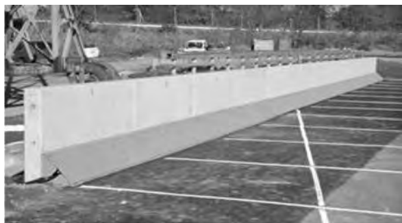
写真一 1 PCa 高欄設置状況 (試験条件 A)
