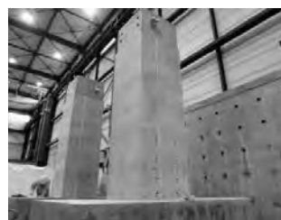
④ 施工完了
