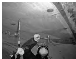
③充填材注入
