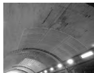
④施工完了
