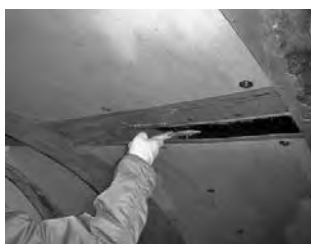
②接合パネル設置
