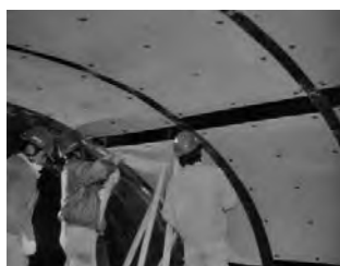
①本体パネル設置
