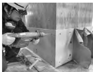
① 本体パネル設置
