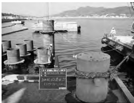
写真一 3 継鋼管杭の挿入
