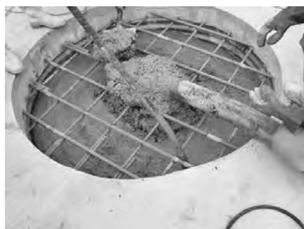
写真一 6 蓋コンクリート打設
