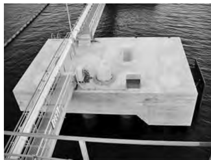
写真一 10 着工後
