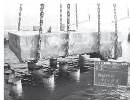
写真—2 既設上部工の撤去
