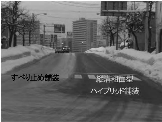
写真一5 施工直後路面露出状況
