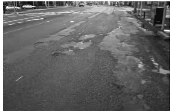
写真-2 排水性舗装の内部破損例
