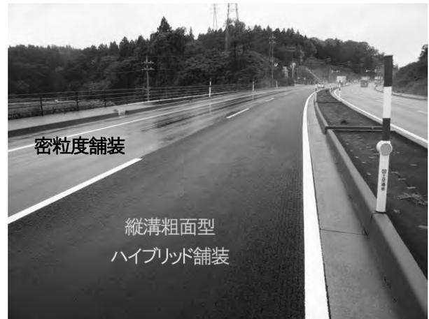
写真一四 縦溝粗面型ハイブリッド舗装浮き水抑制例
