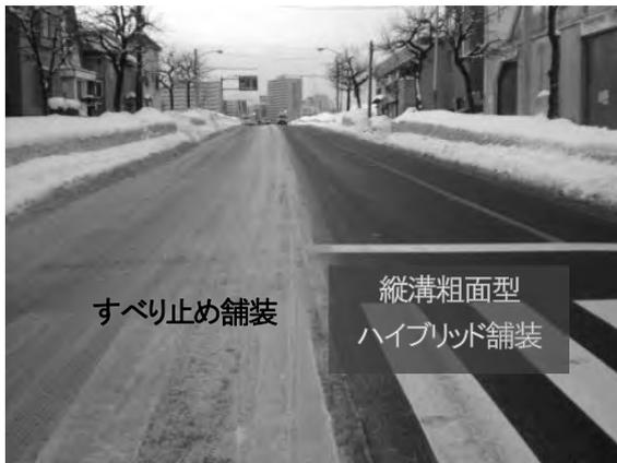
写真一6 施工直後路面露出状況
