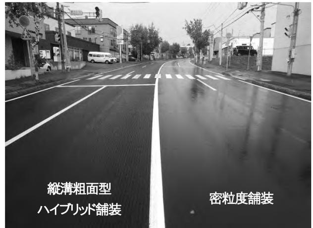
写真一八 施工直後浮き水抑制状況
