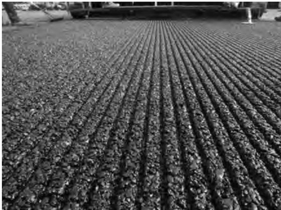
写真-1 縦溝粗面仕上げの例
