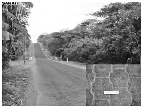
写真一〇 完成したインターロッキングブロック舗装
