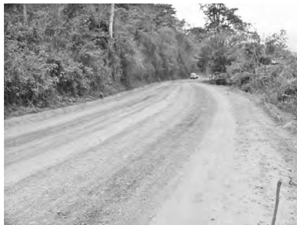
写真一八 施工前 (砂利道)
