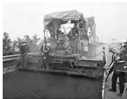
写真-2 敷き均し
