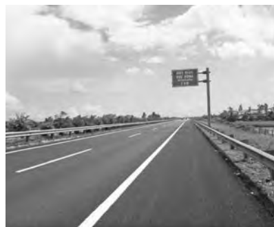
写真-5 完成後の路面
