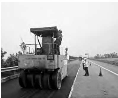
写真-4 二次転圧
