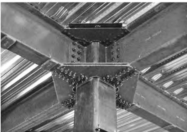
写真-1 本工法を用いた柱梁接合部
