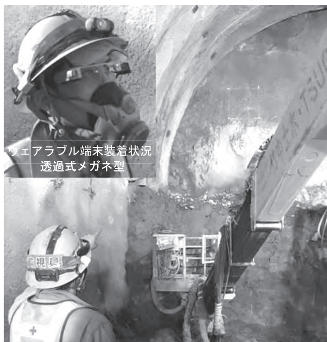
写真-4 切羽監視状況とウェアラブル端末使用状況 3)
