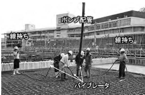
写真-1 従来の一般的な締固め作業
