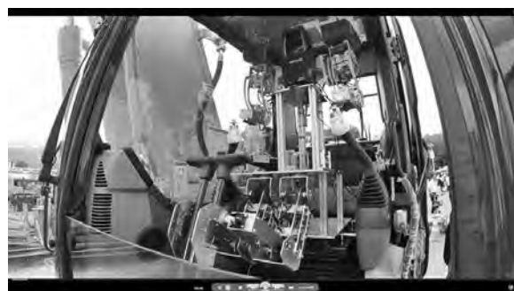
写真—9 DOKAROBO3 号機
