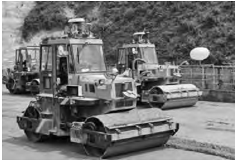
写真一 五ヶ山ダム適用状況
