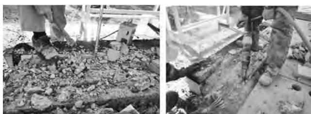
写真一5 後打ちコンクリートの加熱部の破碎
