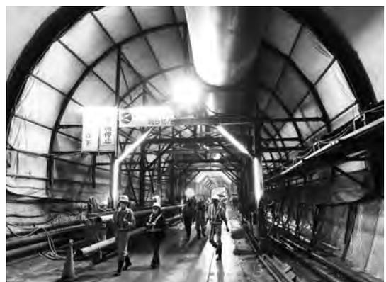
写真一〇 覆工コンクリート養生部
