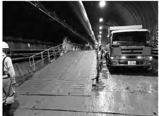
写真一八 インバート栈橋設置状況
