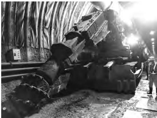
写真一五 ブームヘッダ (カヤバシステムマシナリー(株) RH-250MB-SL)
