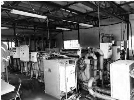
写真-11 放流設備内状況（処理水をポンプにて移送）
