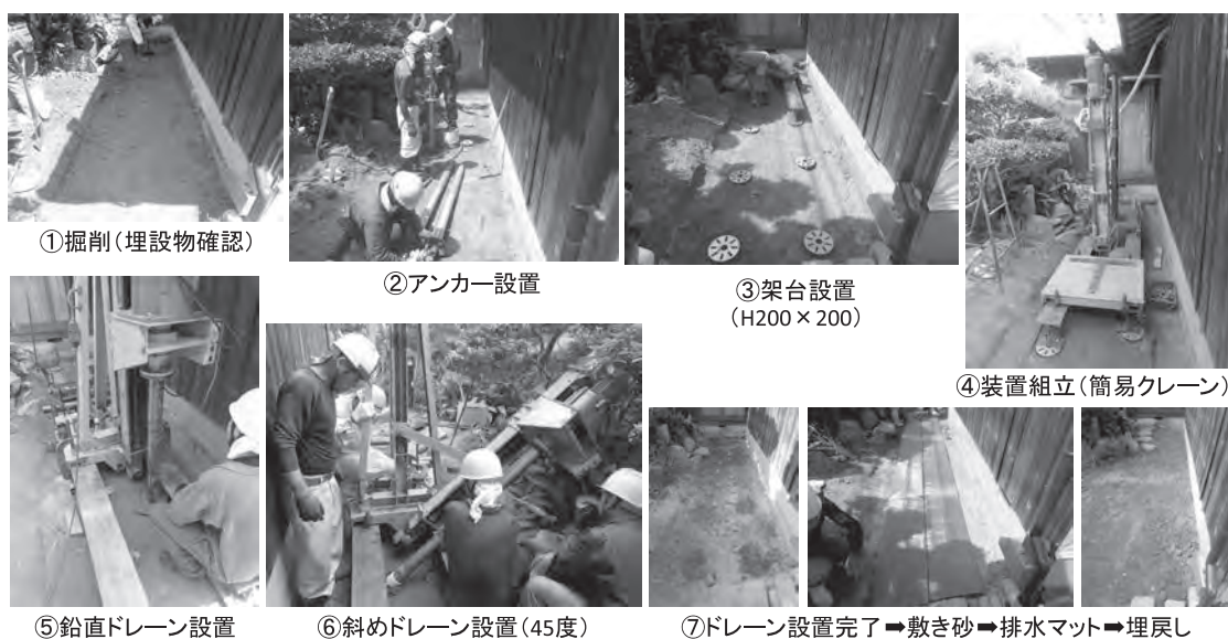
写真—4 作業手順と施工状況
