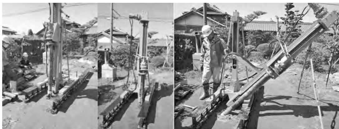
写真—5 低振動低騒音小型回転圧入装置（左：検証実験状況，中央：首振り鉛直施工，右：斜め施工）
