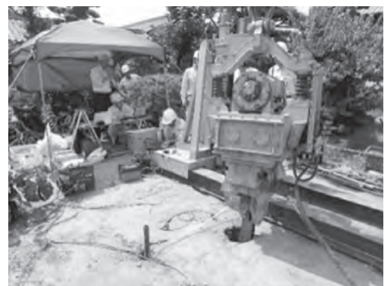
写真—3 パイロによる起振状況
