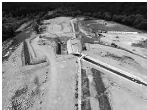
写真一六 三保溪流保全工全景
