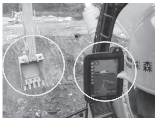
写真一4 MC バックホウによる切土法面整形
