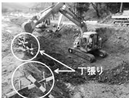
写真一2 従来の土工
