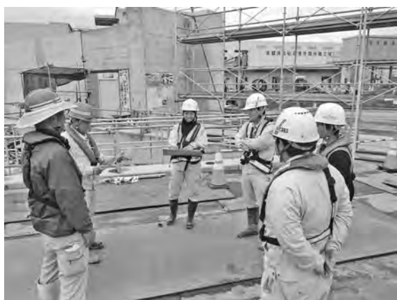
写真—9 現場状況
