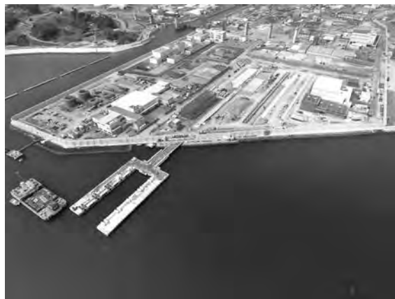
写真—2 現場状況写真（2018年8月22日撮影）
