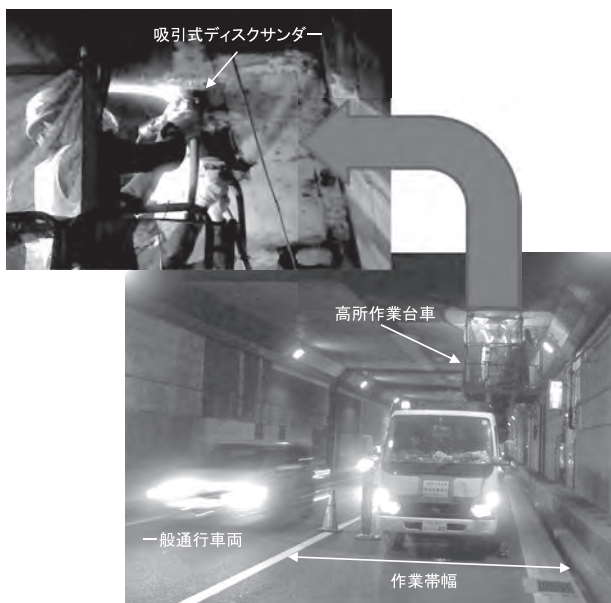
写真—1 一般的な道路トンネル天井面の研掃作業 (人力施工)
