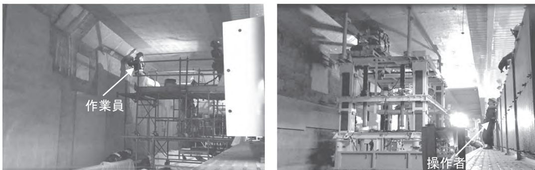
写真－9 地下鉄施設施工状況の比較（左：人力施工 右：研掃装置施工）
