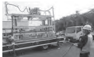
多段式リフターによる研掃装置の上昇と天井面勾配調整
