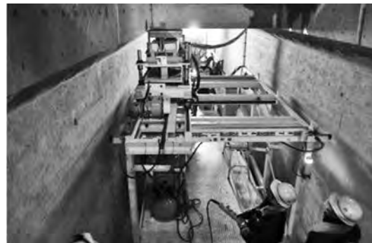
写真—14 放流渠施工状況
