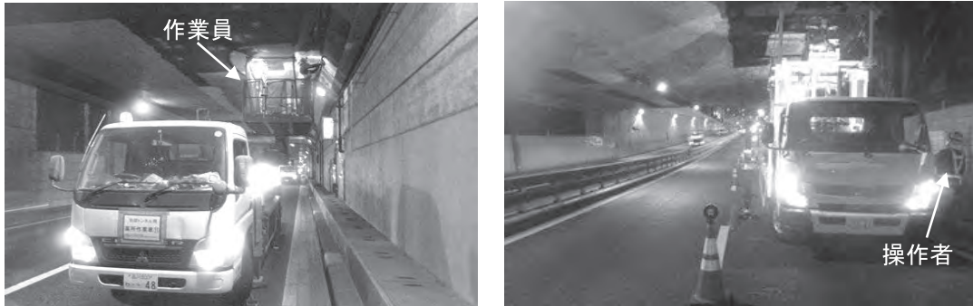
写真－8 道路トンネル施工状況の比較（左：人力施工 右：研掃装置施工）
