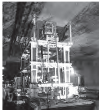
ケレン機による表面処理
