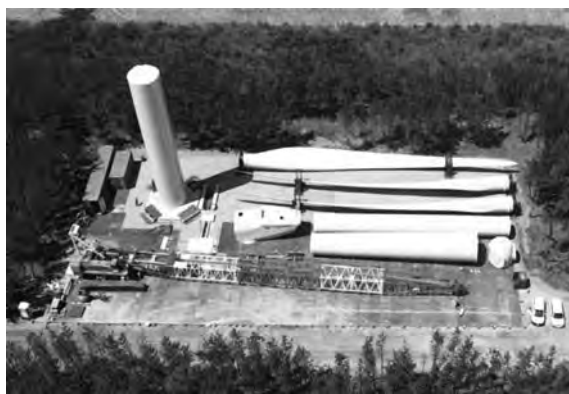
写真—1 風車部材仮置状況
