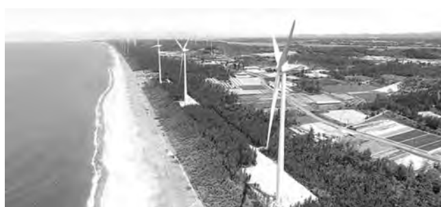
写真—3 風車完成時全景
