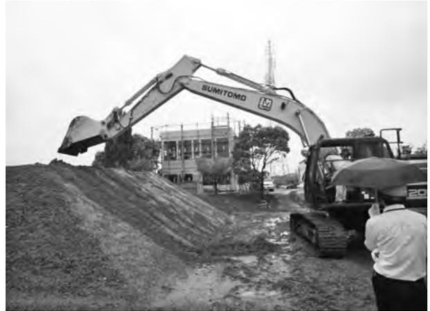
写真-2 MC を利用した法面成形
