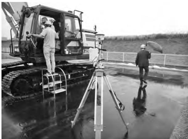
写真一四 基準局から補正情報の送信
