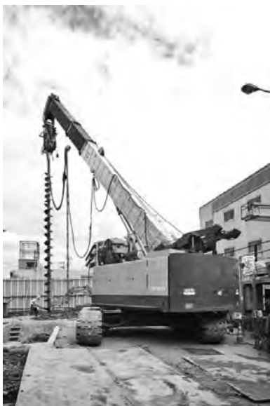
写真-2 プレボーリング工法
