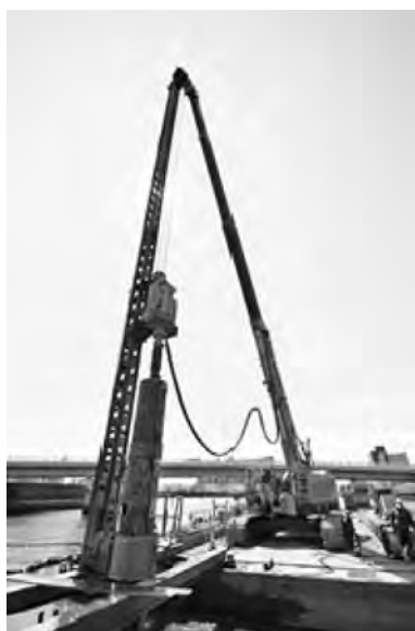
写真-3 オーガケーシング工法
