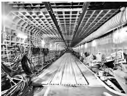
写真—4 坑内状況（坑口より見る）
