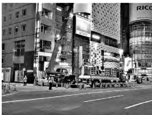
写真二 夜間作業帯設置状況 (①より見る)
