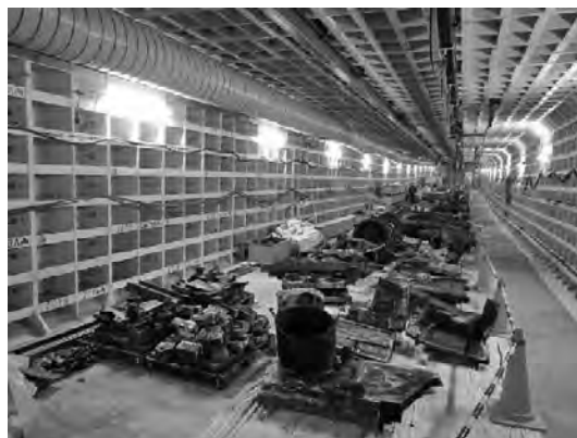
写真—7 解体材坑内仮置き状況
