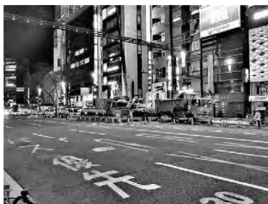
写真三 夜間作業帯設置状況 (②より見る)
