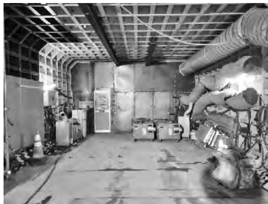
写真— 11 銅製隔壁設置状況
