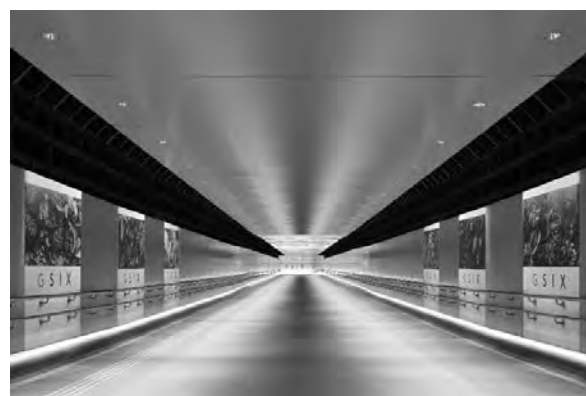
写真—14 完成した地下通路
