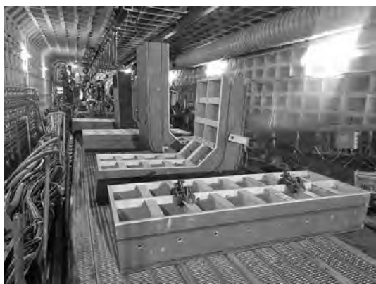
写真—5 坑内セグメント仮置き状況
