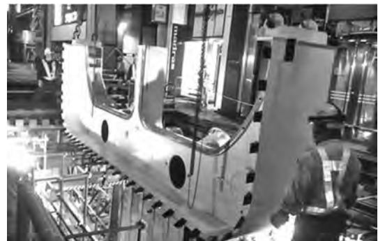
写真一八 前胴部投入状況
