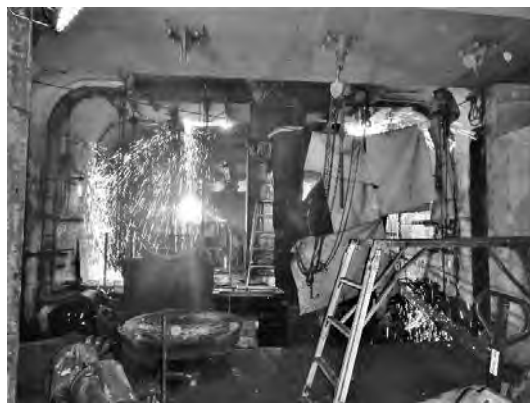
写真—6 シールドマシン解体状況
