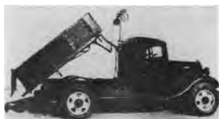
写真-38 矢野式ダンプ機構
