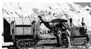
写真-39 牽引クローラダンプ
