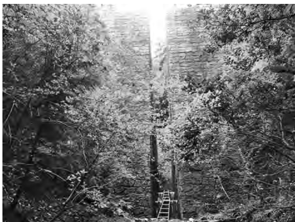
写真—3 六甲の砂防堰堤
