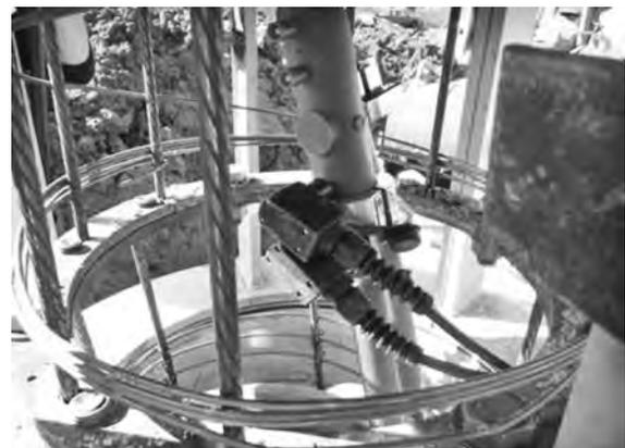
写真一1 専用継手による熱交換器の接続
