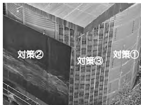
写真—8 骨材冷却対策
