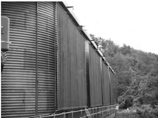
写真—1 遮光カーテン設置状況
