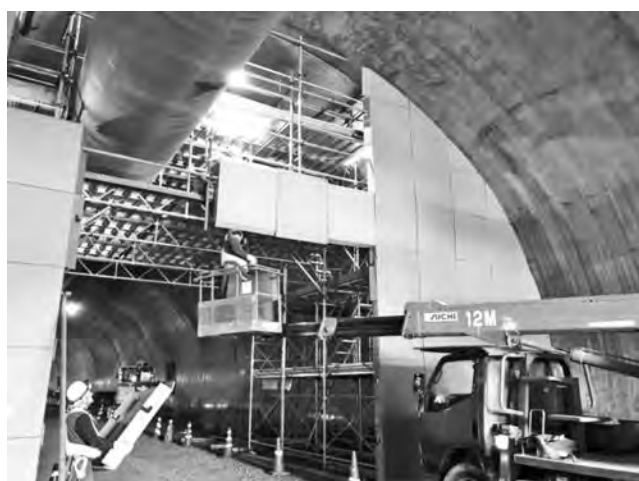
写真一九 高所作業車と人力での設置状況
