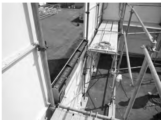
写真—3 騒音低減装置設置状況（単独設置）
