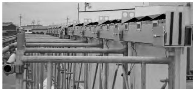
写真―6 本装置設置状況（連続設置）
