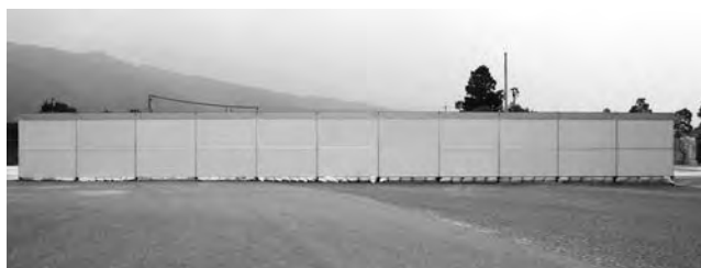
写真―4 正面全景（連続設置）
