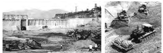
写真一20 信濃川発電所池内掘削とコア締り
