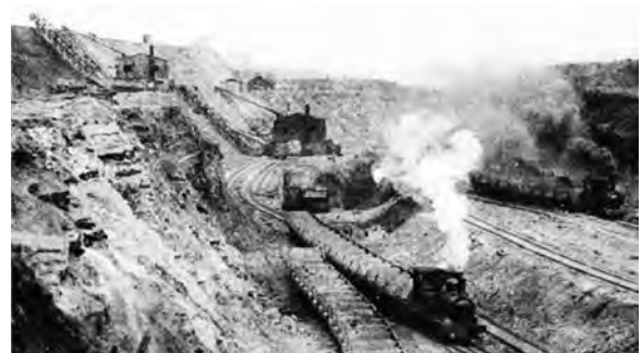
写真一3 高地部掘削のLMG製エキスカと土工機関車
