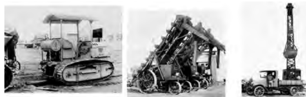
写真一8 独トラクタ、バケットローダ、クラムとトラック
