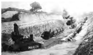
写真-9 烏山頭排水開渠掘削
