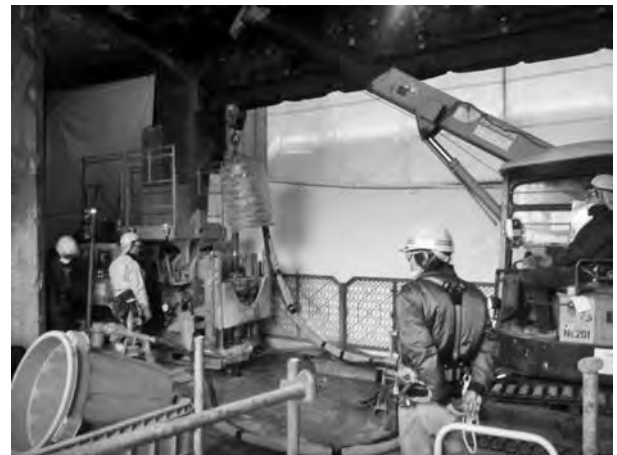
写真一3 施工状況
