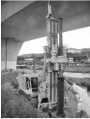
写真一 2 空頭制限下での回転杭工法施工例<sup>9)</sup>
