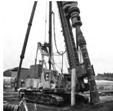
写真一1 斜杭の施工例<sup>6)</sup>
