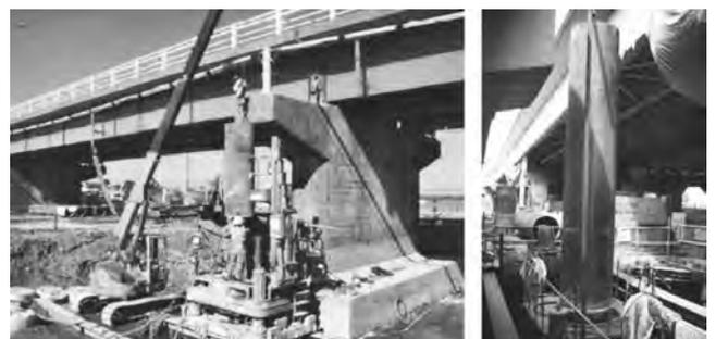
写真一 4 鋼管杭増杭基礎の桁下施工例<sup>11)</sup>
