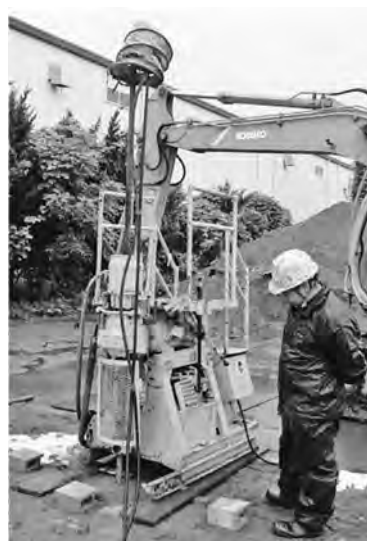
写真—1 注入試験の状況
