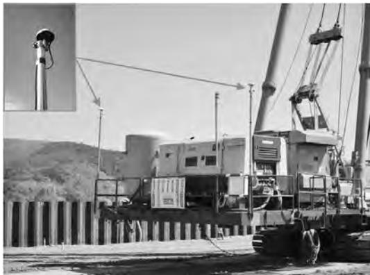
写真一3 GNSS 受信機設置状況
