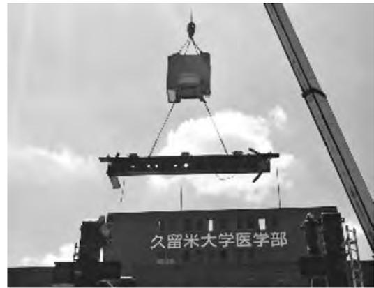
写真—15 吊荷旋回制御装置の現場使用状況
