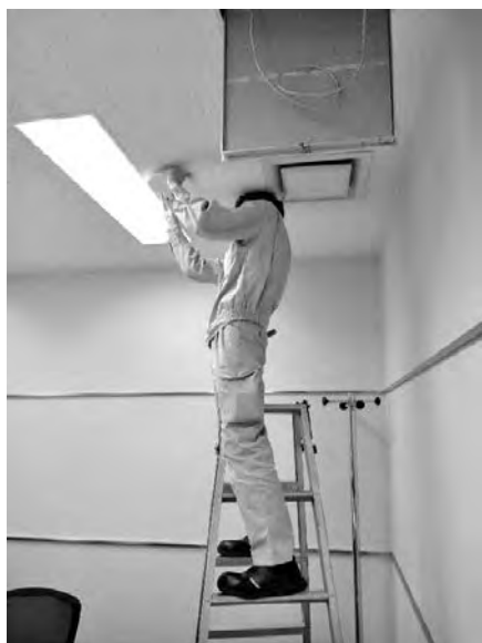
写真一1 ロケーター設置工事
