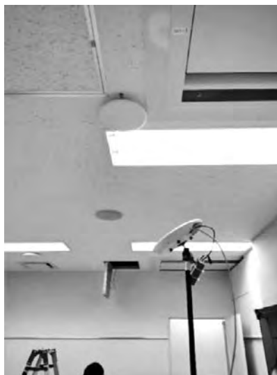
写真一2 専用ロケーターを用いたキャリブレーション作業
