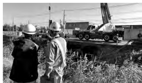
写真一5 監督員立会状況
