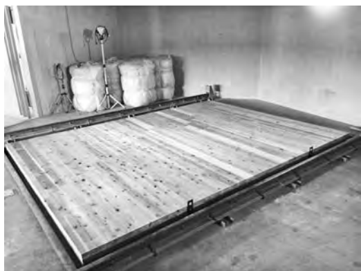
写真—1 CLT 床設置状況
