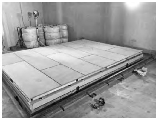
写真—2 二重床設置状況
