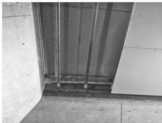
写真—3 天井設置状況
