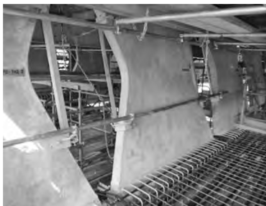
写真—6 バタフライウェブセット完了
