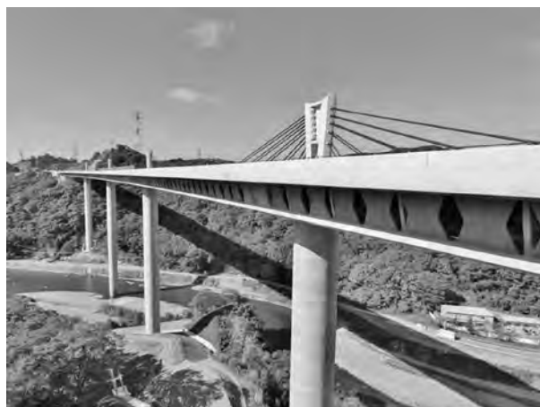
写真—8 武庫川橋全景
