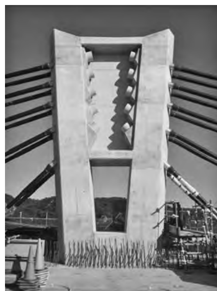
写真ー1 鋼・コンクリート複合主塔構造
