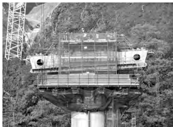
写真—7 ハーフプレキャストによる柱頭部施工
