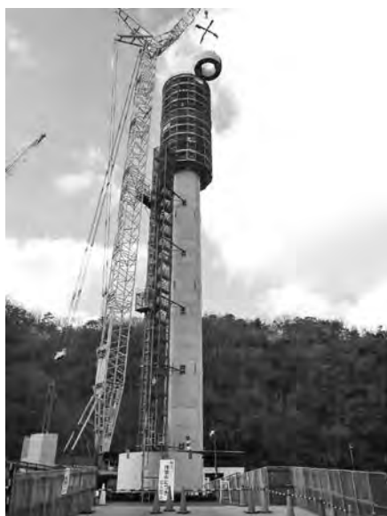
写真一2 橋脚の施工状況
