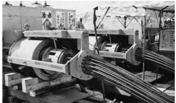
写真-7 ロアリングジャッキシステム
