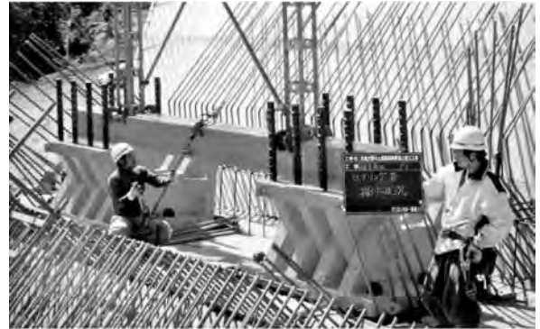
写真-1 ロアリング用回転支承
