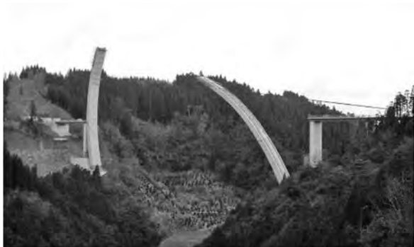
写真-5 P2側ロアリング
