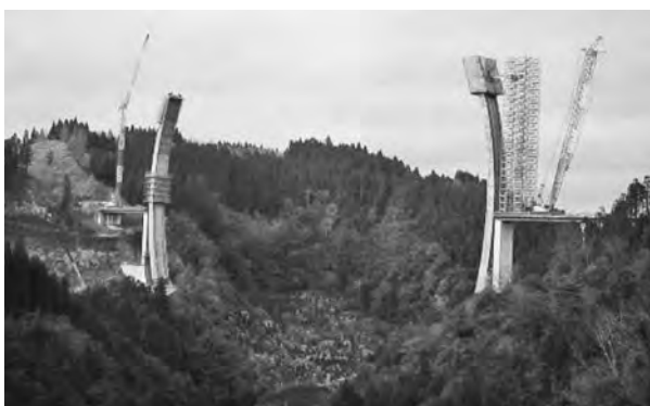
写真—3 アーチリブのクライミング施工状況
