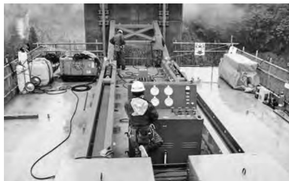
写真—4 アーチリブの角度調整装置
