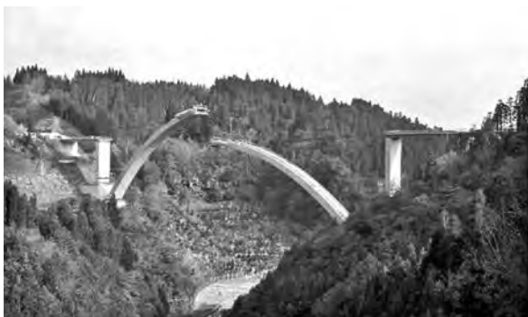
写真-6 P1側ロアリング
