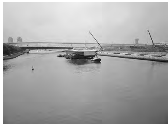
写真一 4 有明北橋通過直後の大ブロック
