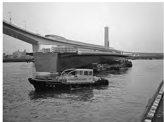
写真一 3 1,500tのバラストを入れて離岸する輸送台船
