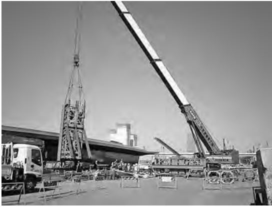
写真一五 200tクレーンによるリフトアップ設備組立
