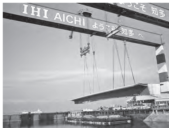
写真一1 ゴライアスクレーンによる浜出し
