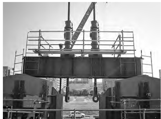
写真一七 ジャッキングホイスト
