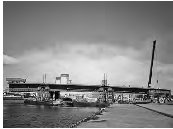
写真一六 大ブロック延長 (台船縦着け)
