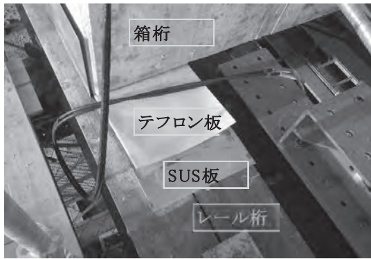
写真-4 レール桁
