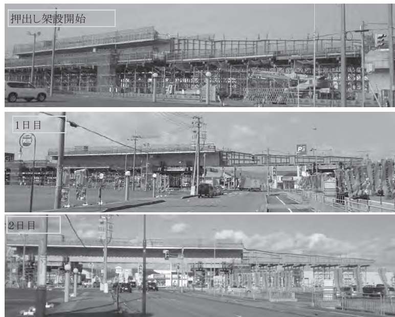
写真-10 施工実績
