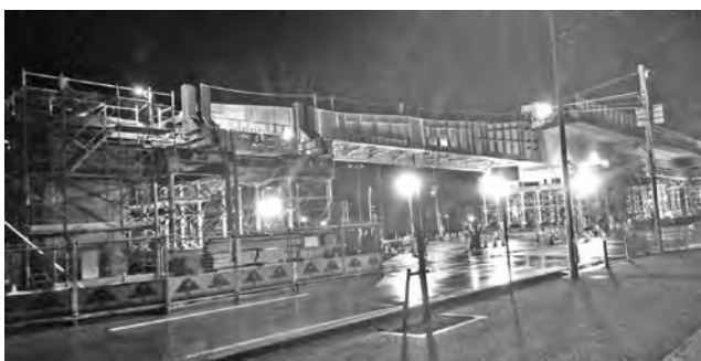
写真-11 施工状況
