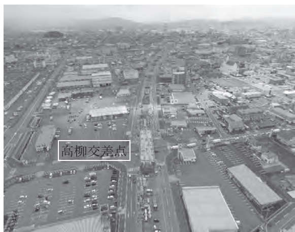
写真—1 県道の中央に走る新幹線 第2高柳Bv架設完了状況
