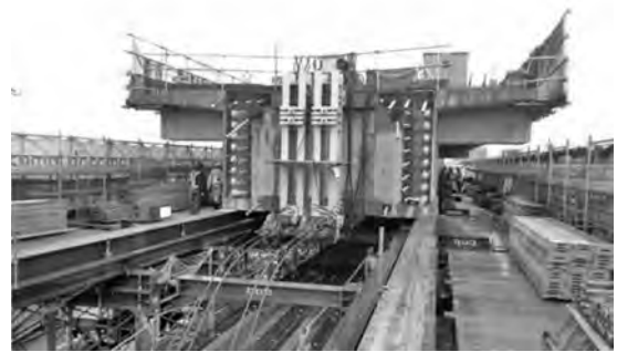
写真-2 押し出し架設状況
