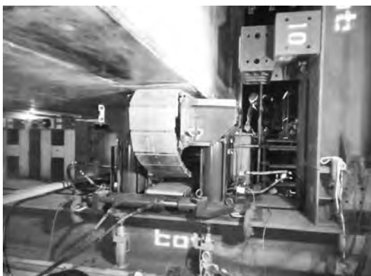
写真一8 エンドレスジャッキ使用状況
