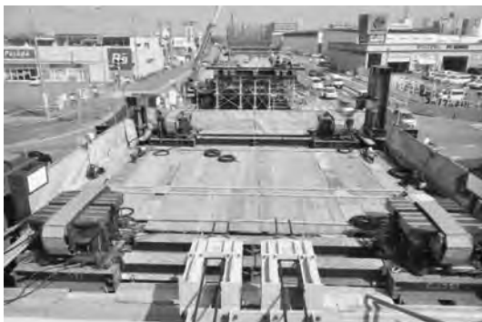
写真一7 エンドレスジャッキ配置状況
