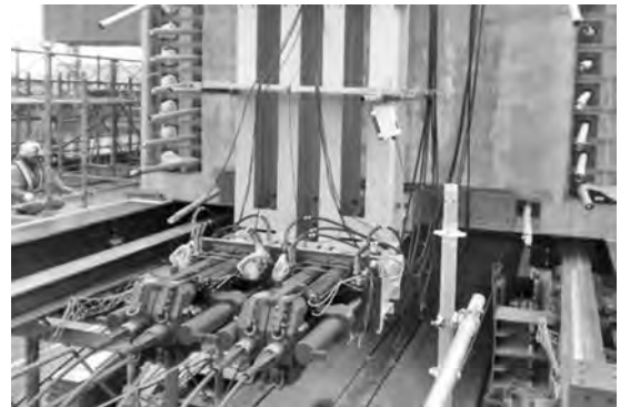
写真-3 ジャッキ設置状況
