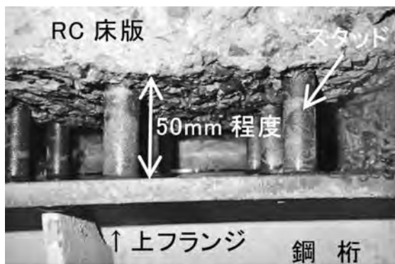
写真—2 WJによる接合部コンクリート除去状況
