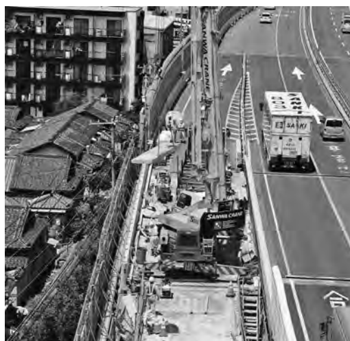
写真—1 阪神高速道路における床版撤去
