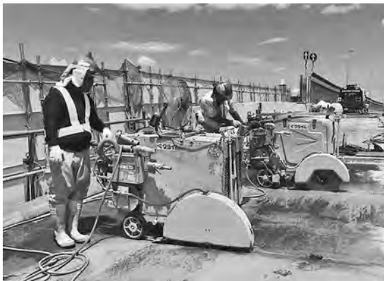
写真—3 複数台による床版切断状況
