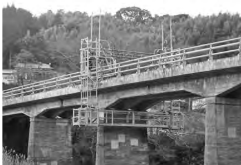
写真一2 本装置の設営状況
