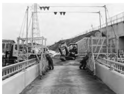
写真—6 重量規制橋梁における設営状況
