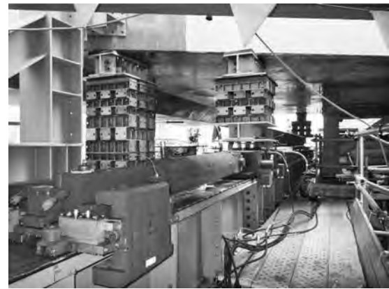
写真一四 引き戻し用ジャッキ
