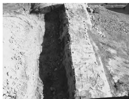
写真－9 パラウェブ・マット設置（発破前）
