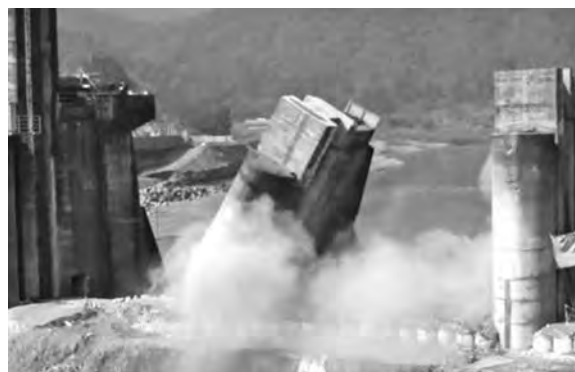
写真-2 発破の状況
