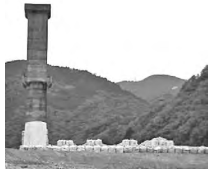
写真—3 振動対策盛土
