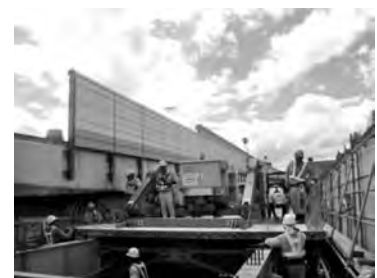
STEP ⑥ UFC 床版架設
