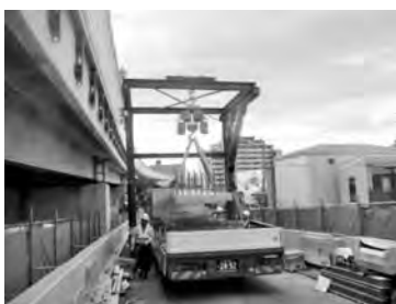
STEP ① UFC 床版搬入荷降し
