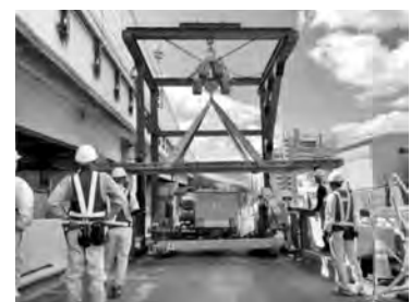
STEP ③ 専用架設機床版下通過
