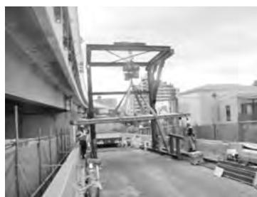
STEP ② UFC 床版吊上げ旋回
