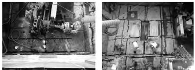
写真-5 分割削孔状況(左), 同完了全景(右)
