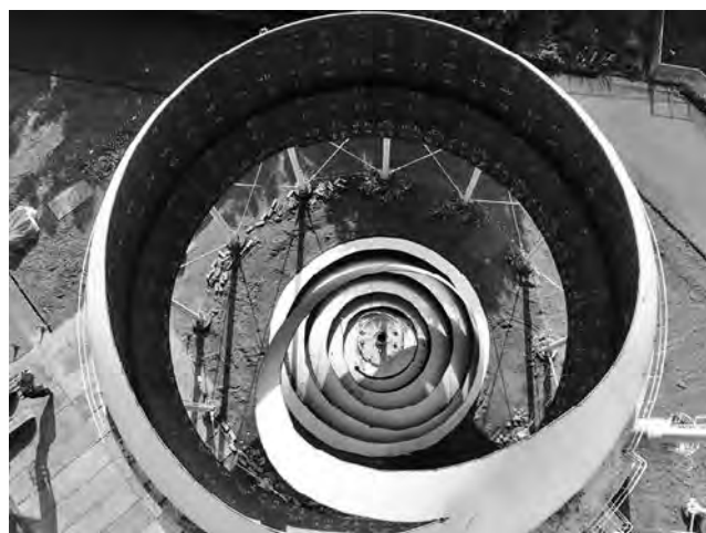
写真—1 本工法施工状況 上空から
