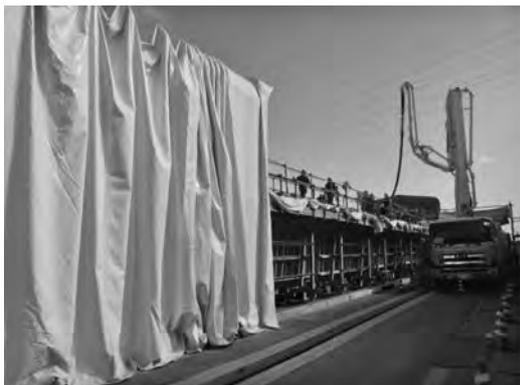
写真一5 U桁打設状況
